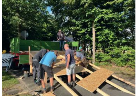
Aufbau der Rampe
