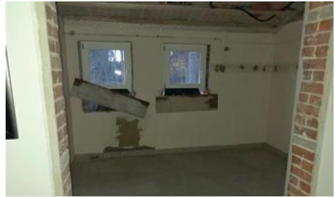
Das neue Pfarrbüro in der Entstehung
